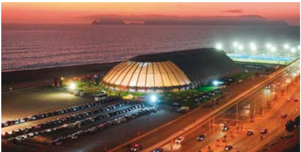
RECINTO TIENE DEFICIENCIAS.
