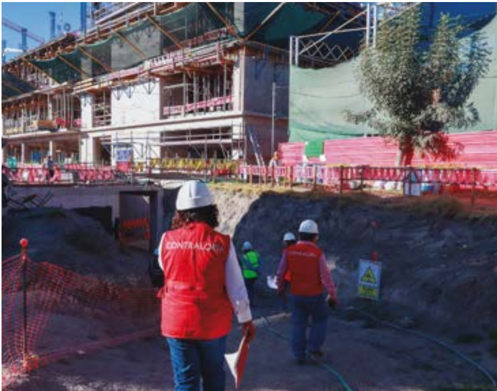
OBRAS VAN A PASO LENTO.
